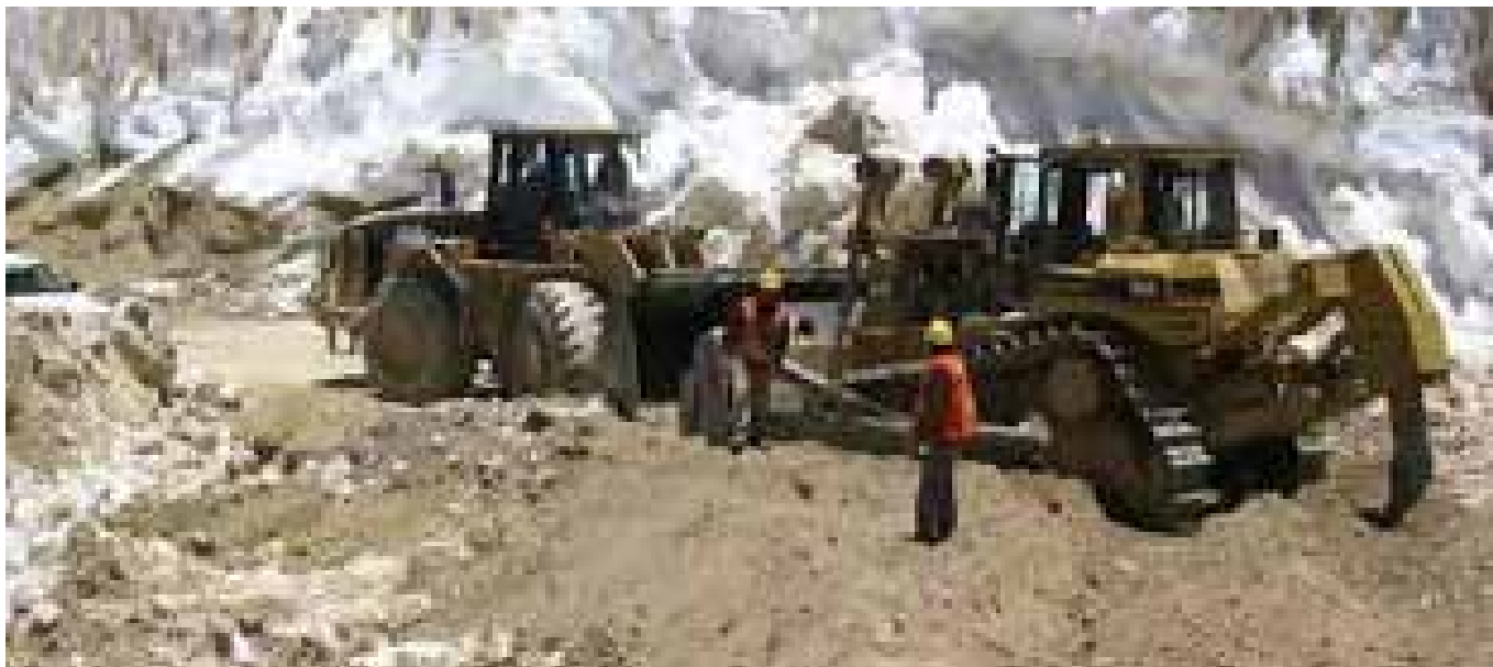
Obras sobre glaciar Brown Superior. Construcción camino minero.
